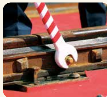
レールの継ぎ目ボルトを締め付ける様子
