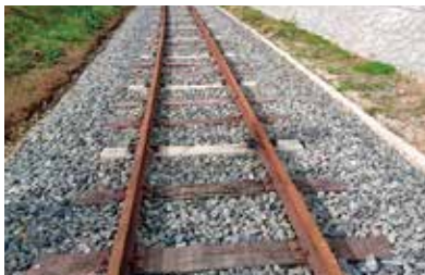
長陽駅～中松駅間 復旧した線路軌道
