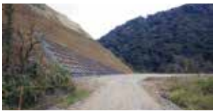
犀角山トンネル 撤去前（上段）
