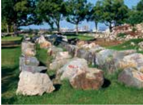
同じ位置に復元するため整理された崩れた石垣
