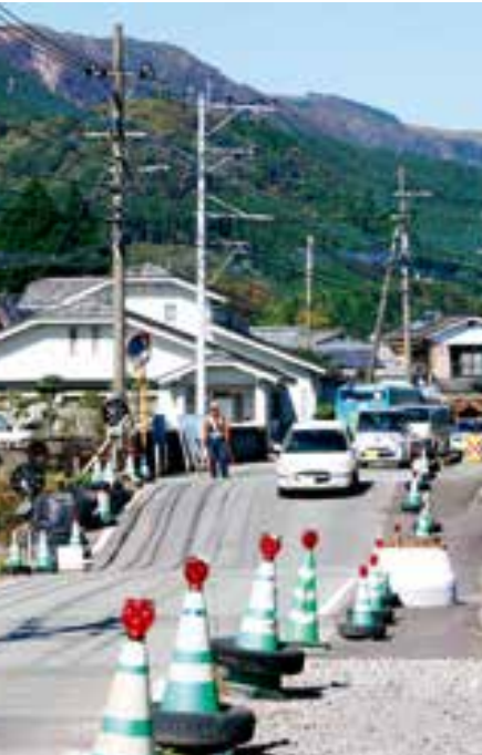
地盤沈下で寸断された道路も現在は通行できる(阿蘇市)
