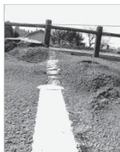
▲駐車場のアスファ ルトを根が押し上 げる。
