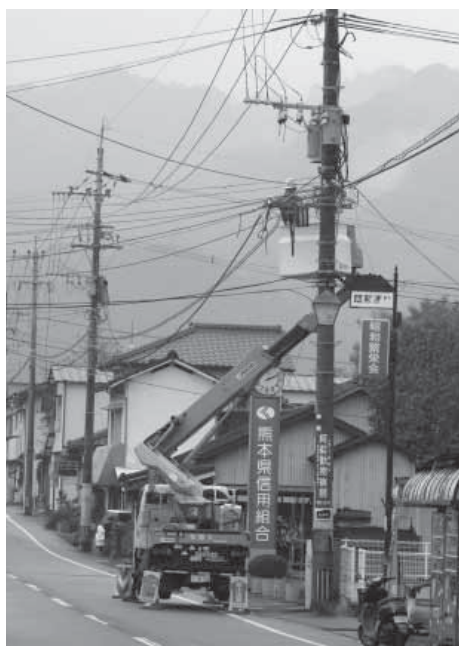
▲光ケーブル敷設作業のようす（高森地区）
