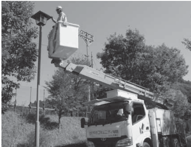
▲高所作業車を活用し、街路灯の清掃を行いました
