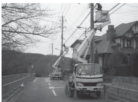
▲バケット車の作業のようす
