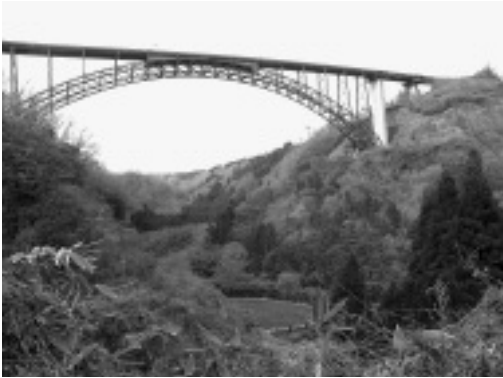
▲忠敬測量隊が測量した川走川の谷底の道から見上げる位置に架かる奥阿蘇大橋
