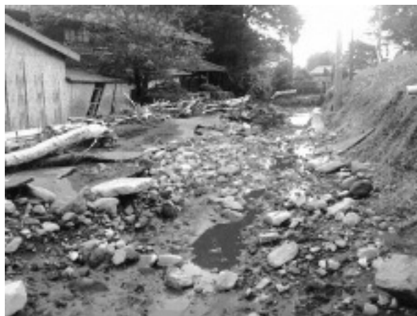
▲上色見中原地区では広範囲にわたって道路が崩壊した（大村・前原線）
