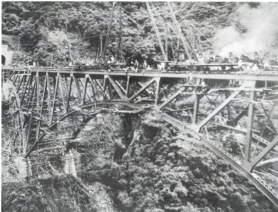
▲大正15年に着工し、昭和2年10月頃に完成した第一白川鉄橋。両岸から跳出式に組み立てて、中央部で結合するという当時ではめずらしいアーチ橋でした。
