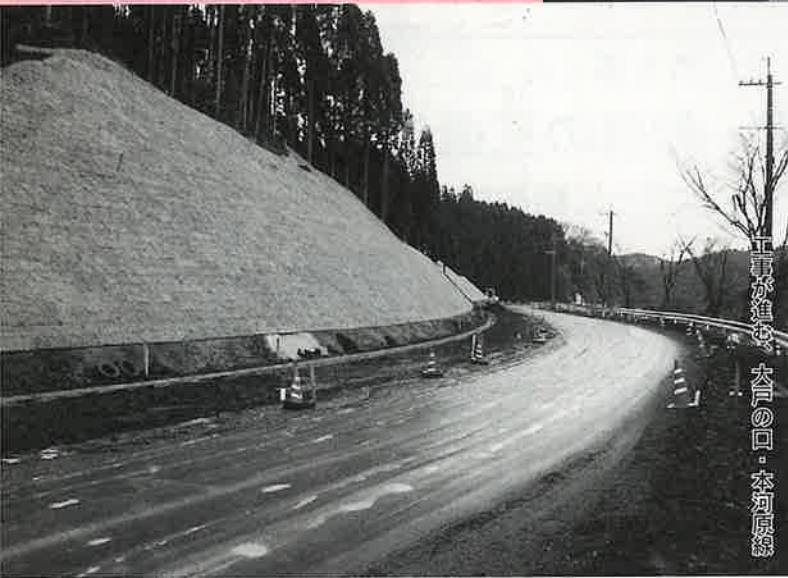
高森町役場・建設課・土木係 2-1111 内線 163 番
