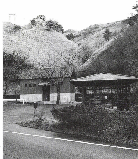
高森トンネルの県の公衆トイレ
