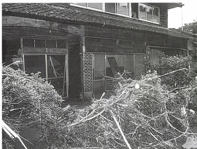
筑の谷川の氾濫により被害を受けた民家（上津留）
