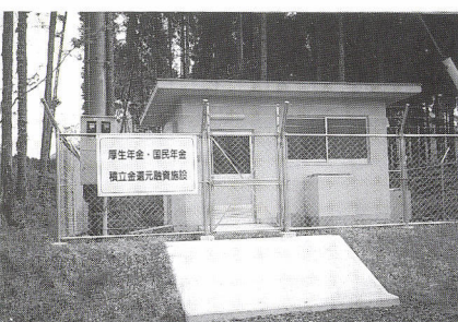
新しく完成した小倉原水源
