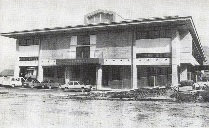
3月に完成した高森中学校体育館
