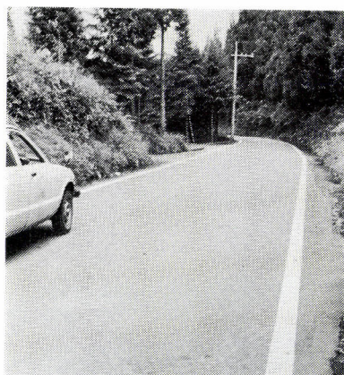
舗装が進む町道黒岩一大戸の口線
