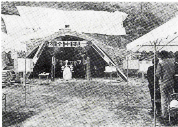
草部トンネル工事現場での安全祈願祭
