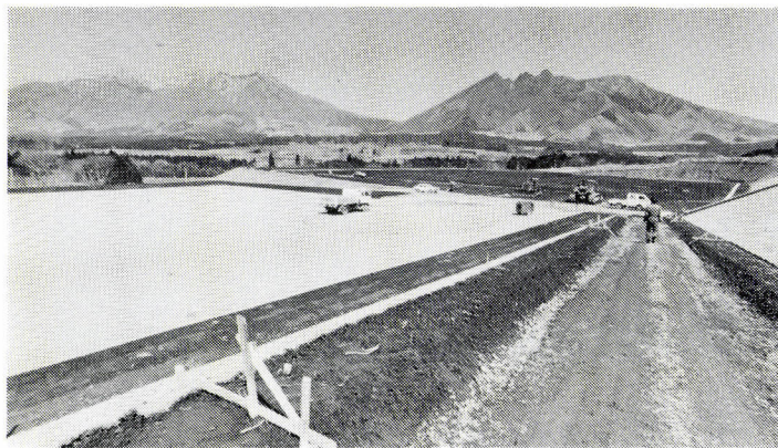
10月完成をめざして工事が進められている総合グラウンド
