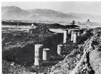
林業センターの基礎工事
