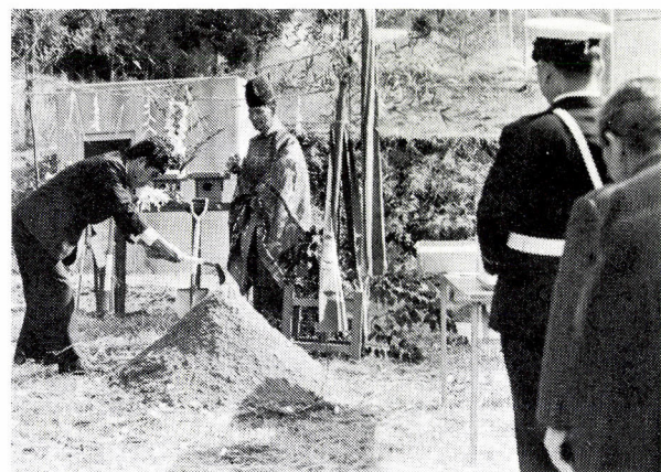
簡易水道工事現場で安全を祈る関係者
