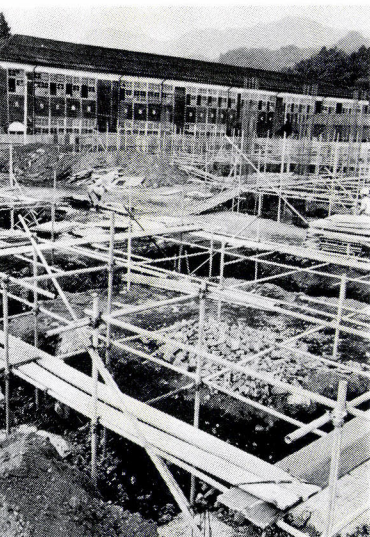
高森小学校の第一期改築工事現場
