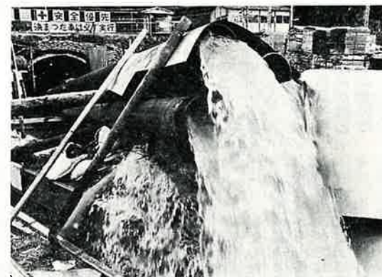
写真中は味岡第8師団長(中央)に断水の状況を説明する岩下高森町長。写真下はトンネル工事現場から排水される地下水
