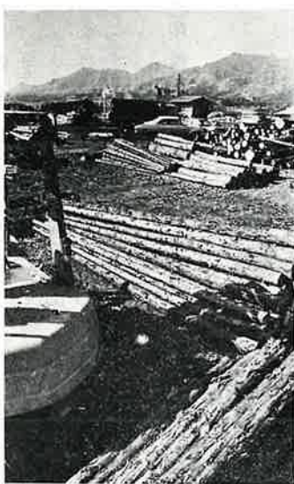
第二次林業構造改善事業で完成した山元貯木場
