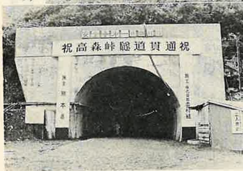
祝賀アーチのかかった新高森トンネル入口
