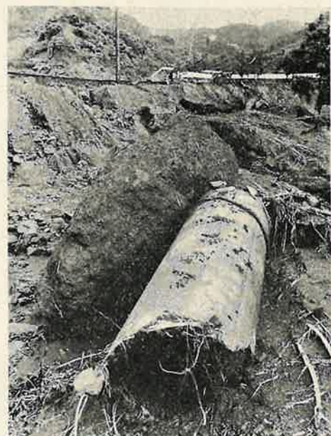
高森峠の国道も大打撃(3合目付近)
