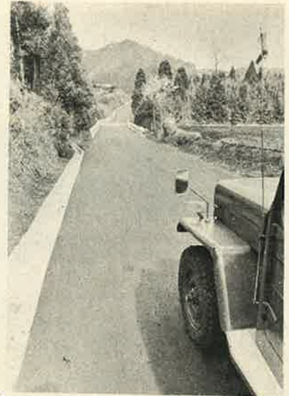
改良舗装された色見環状線
