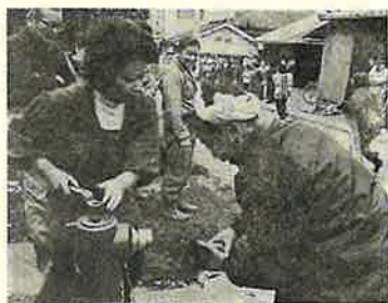
消火栓を使っの防火訓練
