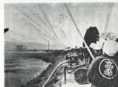
写真上は町長の通常点検を受ける地元消防団 写真下は別所の堤で行なわれた一斉放水
