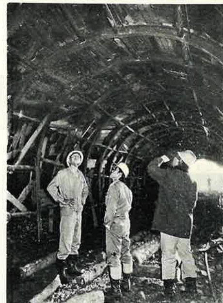
↑国道265号線道路改良工事は高森峠のト ンネル掘削から始められました。
