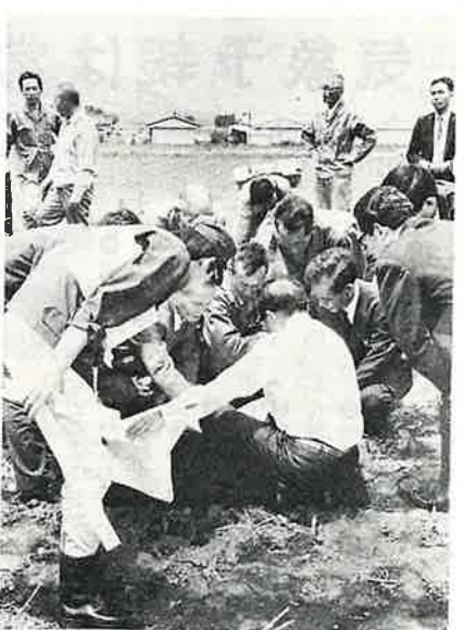
南在の現地で鉄建公団職員から工事説明を聞く住民たち
