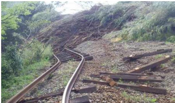
写真 激しい軌道変状
