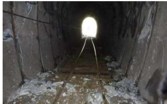
写真 犀角山トンネル内の亀裂
