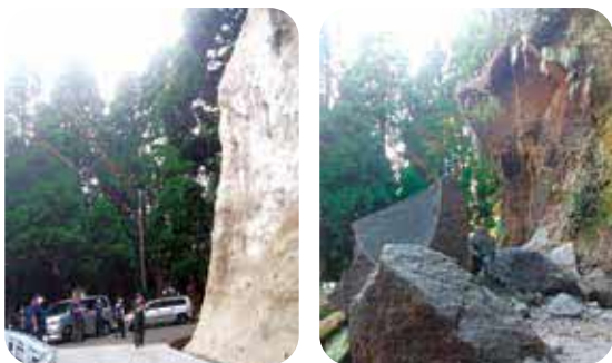
町道社倉・水迫線 工事完了後 ← 落石崩落箇所
