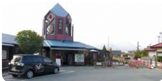
工事中の高森駅周辺
