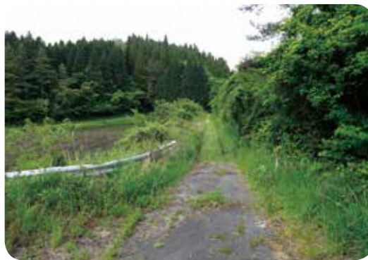
町道廃止検討中の道路
