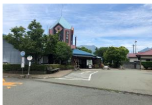
駅前広場の現況
