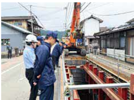
町内現地確認の様子 (市街地無電柱化工事の現場)
